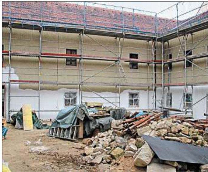
Der Innenhof ist derzeit gefüllt mit historischem Baumaterial. Nach der Aufbereitung soll es wieder für das Gebäude verwendet werden. Foto: Heike Praschel
